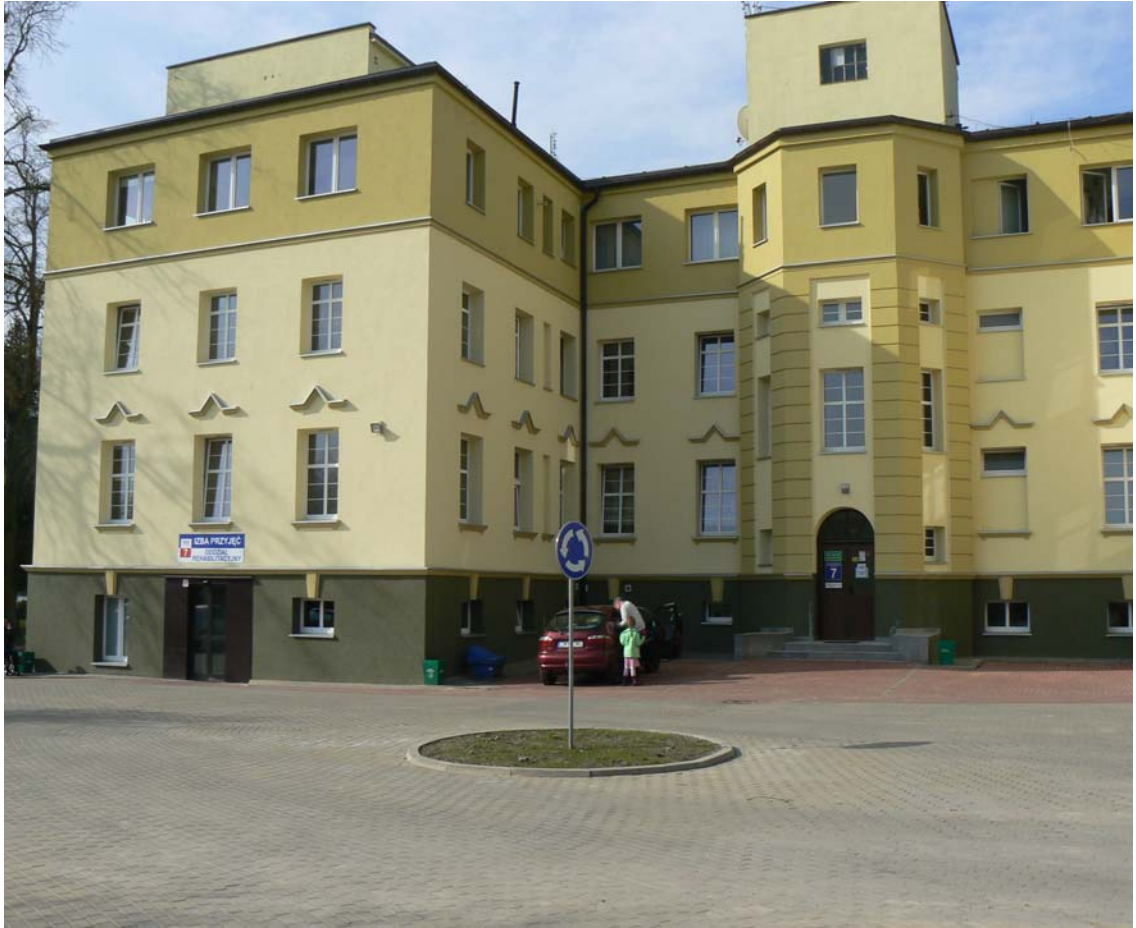
budynek po remoncie
