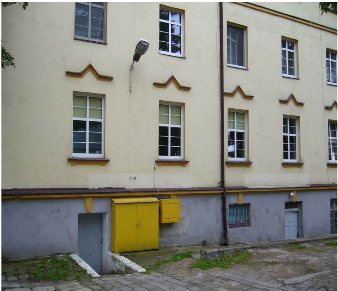
budynek przed remontem
